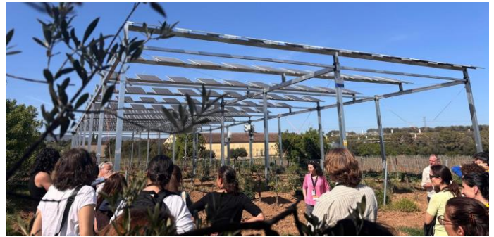
Foto 13. Instalaciones agrivoltaicas experimentales del GO SOLARWINE.
