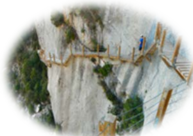
Pasarelas. Tramo I
