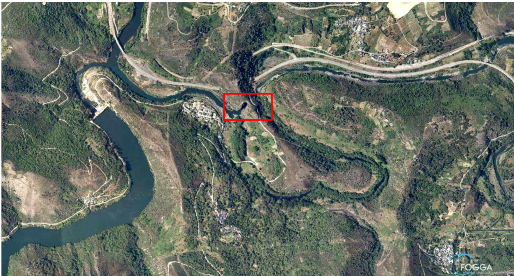
Vista aérea da zona
