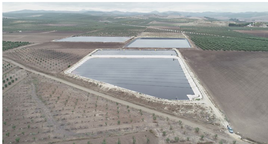
Imagen 6: Balsas de evaporación de efluentes de la entamadora
