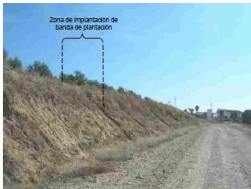
Fotografía 5: Talud de borde de camino público de acceso a la finca
