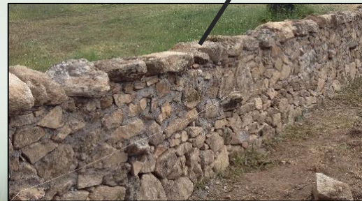
Muros de piedra seca y terrazas de retención
